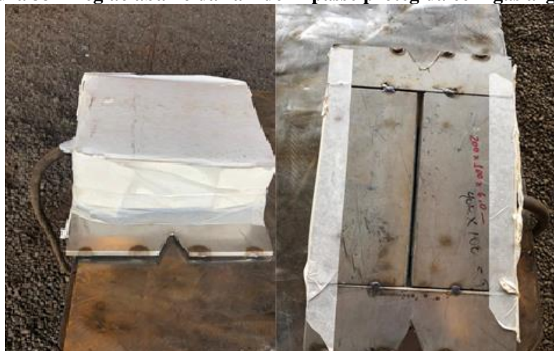
Figura 33 - Região abaixo da raiz do 1º passe protegida com gás argônio.
