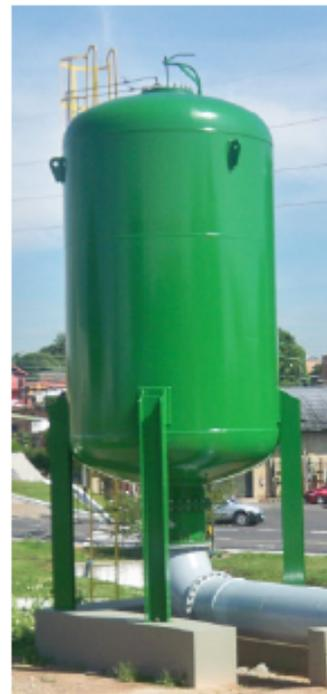
Seção III, para vasos de pressão é usado para o dimensionamento, fabricação e inspeção de todos os **HYDRAMER®**. Para garantia da qualidade total dos fornecimentos, todos os **HYDRAMER®** são submetidos a teste hidrostático de pressão conforme a norma citada ou 1,3 vezes a pressão nominal.
