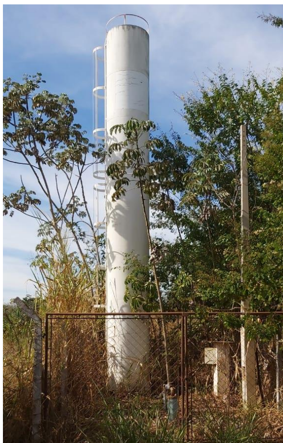
Figura 16. Caixa d'água coletiva do Núcleo Dandara
