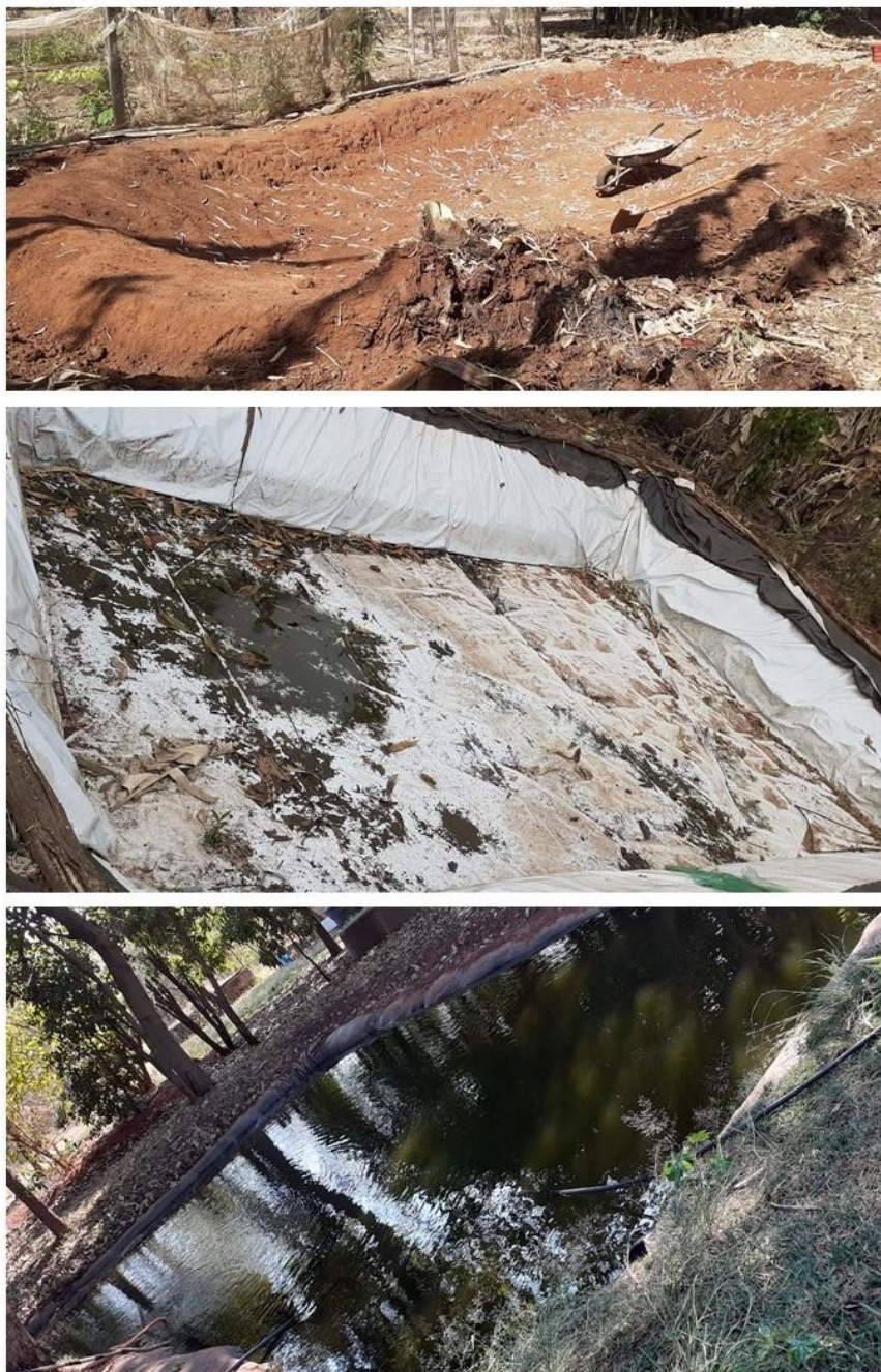
Figura 17. Reservatórios de água do Sepé Tiaraju em momentos e lotes distintos.
