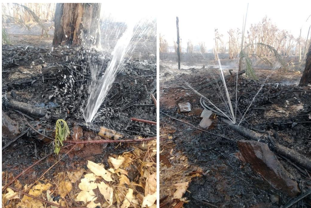
Figura 19. Sistema de distribuição de água após queimada no Assentamento Sepé Tiaraju.
