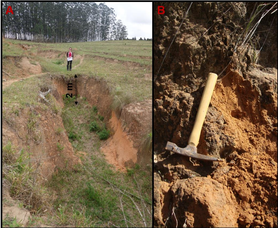
Figura 24. a) Destaque para uma das ramificações da voçoroca associada ao solo pouco coeso de textura arenosa b) Destaque para a textura arenosa.
