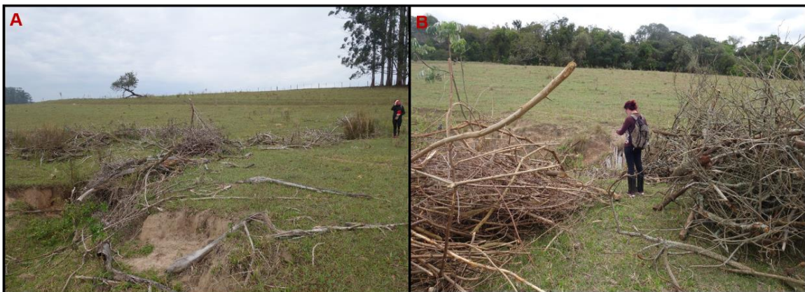
Figura 40. a) Barreira de galhos aplicada em uma das ramificações da principal feição erosiva da sub-bacia. b) Detalhe das dimensões e condições da barreira de galhos.
