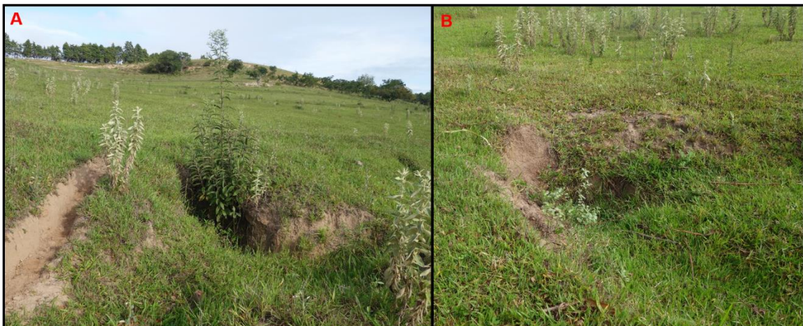
Figura 30. a) cabeceira próxima as estacas 1,2 e 3. b) erosão decorrente do rompimento de terraço.
