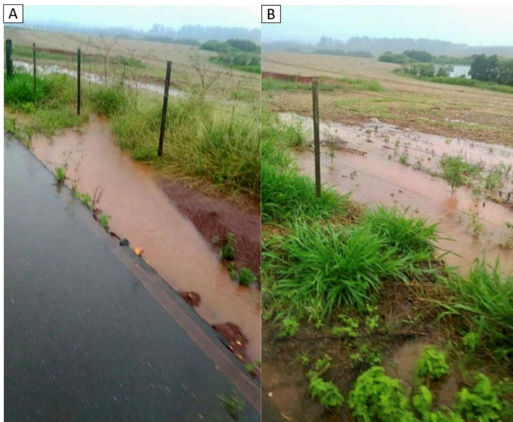
Figura 10 - Local com acúmulo de água de escoamento superficial. Em A, visualiza-se o acúmulo diretamente na área onde ocorre o sulco, e em B o acúmulo de água já avança a área de cultivo
