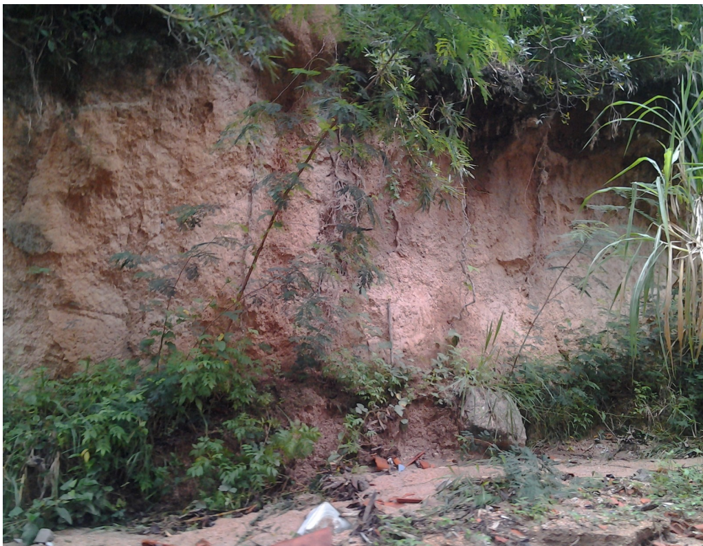
Figura 28: Talude nos limites da Bairro do Brigadeiro Tobias
