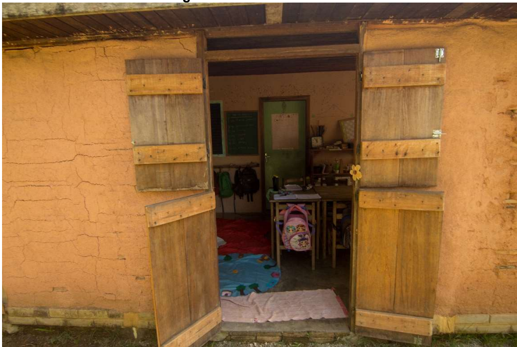
Figura 10 – Parede da escola
