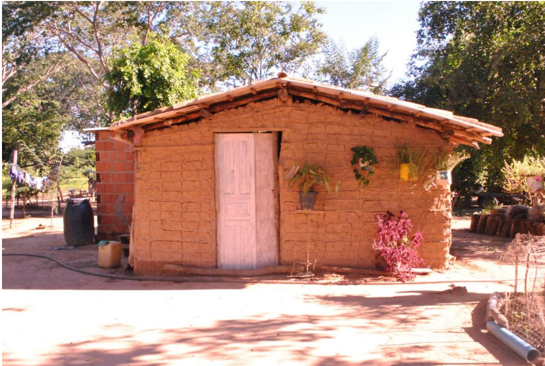
Figura 23 - Casa de enchimento Fotografia: Izadora Acypreste, 2018.
