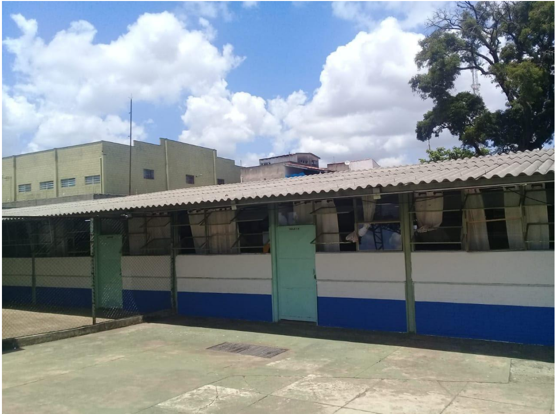
Foto 2: Telhado das salas de aula. Augusto (2019).
