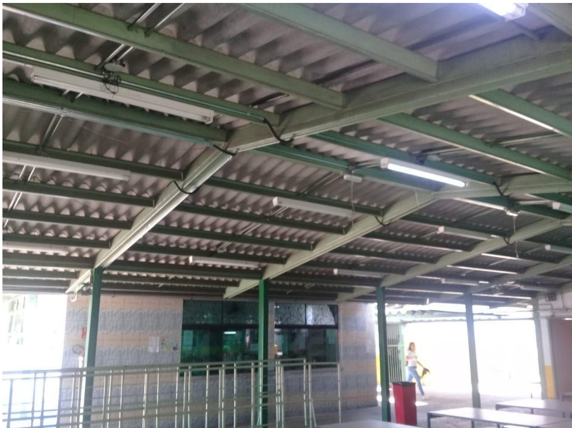
Foto 3 : Telhado do pátio. Augusto (2019).
