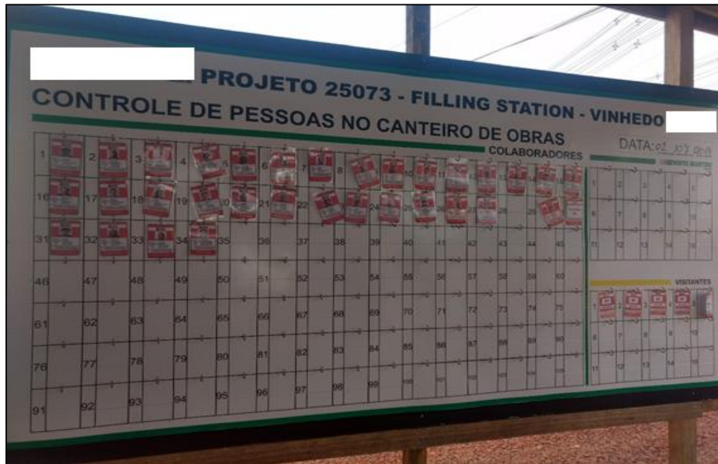
Figura 28 - Quadro para controle da entrada de pessoas no canteiro
