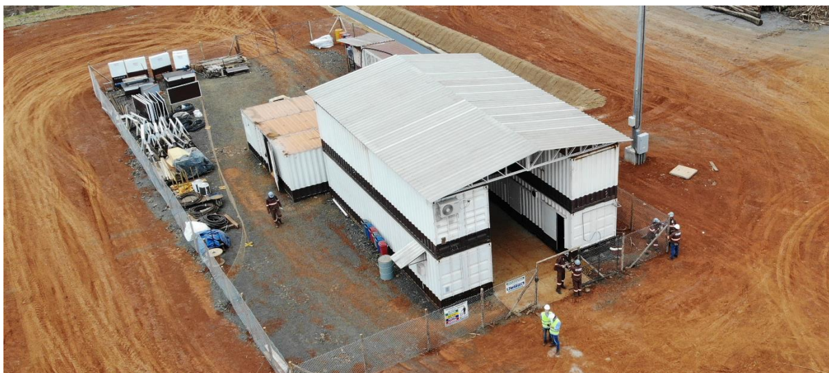
Figura 25 - Vista aérea das áreas de execução de serviço no canteiro D
