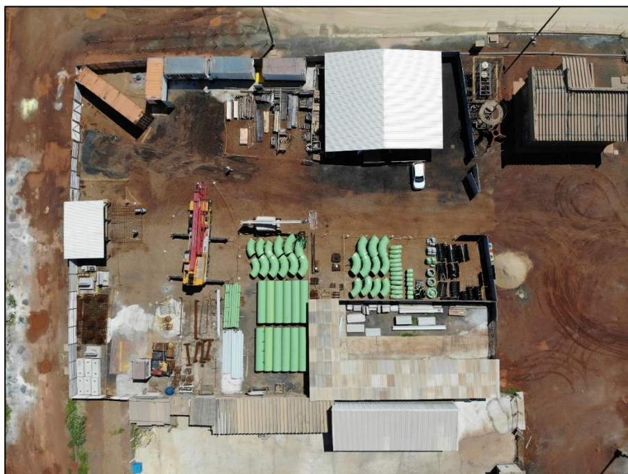
Figura 21 - Canteiro de obras C
