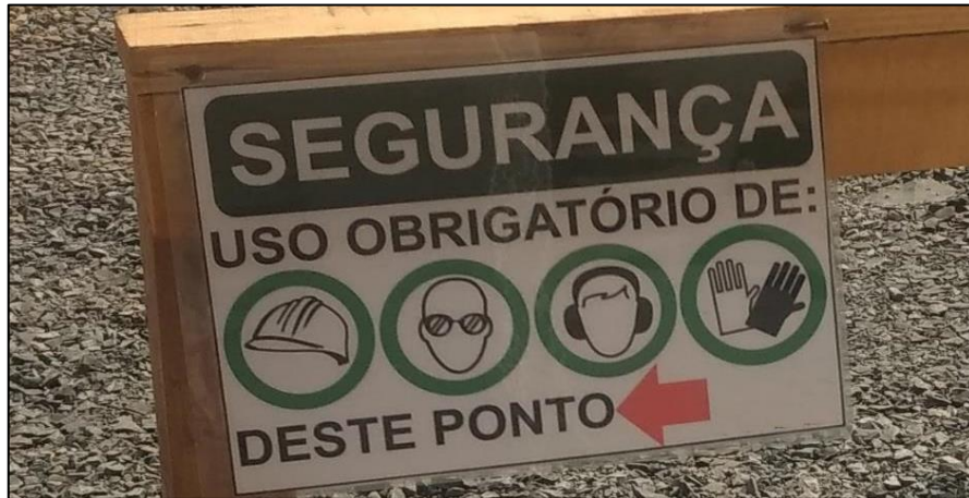
Figura 37 - Placa de segurança para utilização de EPI
