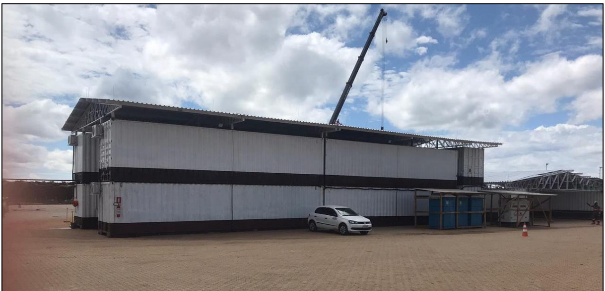
Figura 27 - Vista lateral das instalações provisórias do canteiro E
