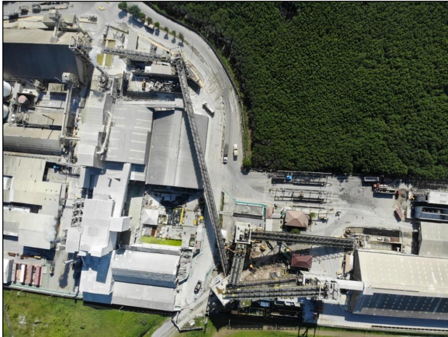
Figura 19 - Vista aérea do projeto B
