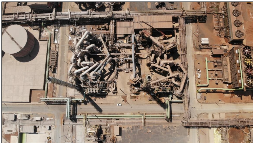
Figura 23 - Vista aérea das áreas do serviço em conclusão no projeto C
