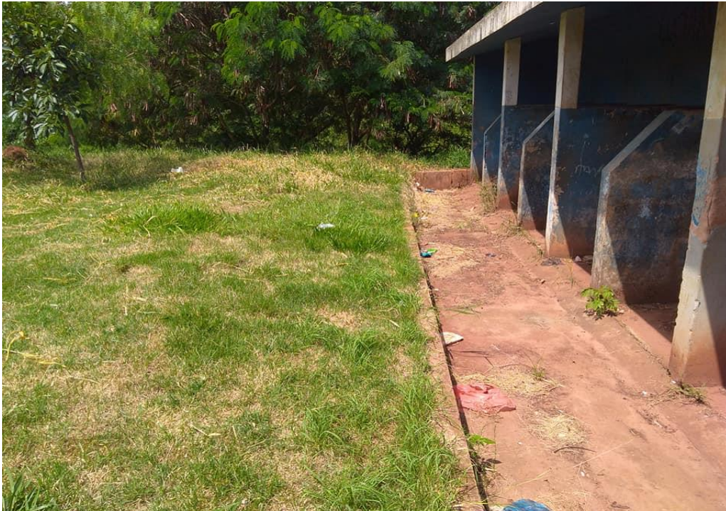
Figura 31 - Lavanderia pública na Vila Beira Rio em Itaí -SP
