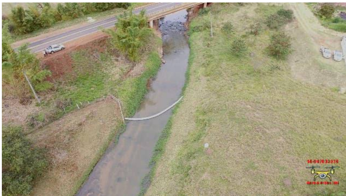
Figura 24 - Imagem captada por drone do local onde localiza-se a ecobarreira 1
