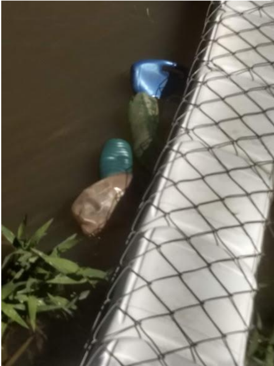
Figura 19 - Ecobarreira construída e implantada no Ribeirão dos Carrapatos em Itaipava - SP
