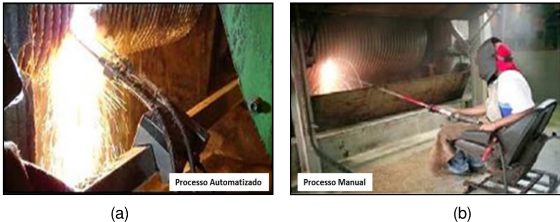
Figura 3.7 – Imagem da aplicação de revestimento tipo chapisco. (a) Forma automatizada e (b) Forma manual.
