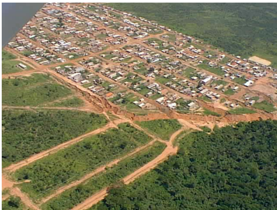
Figura 2.2.2.2 – Panorâmica do bairro Antenor Garcia. Em detalhe erosão devido às chuvas de 1999.
