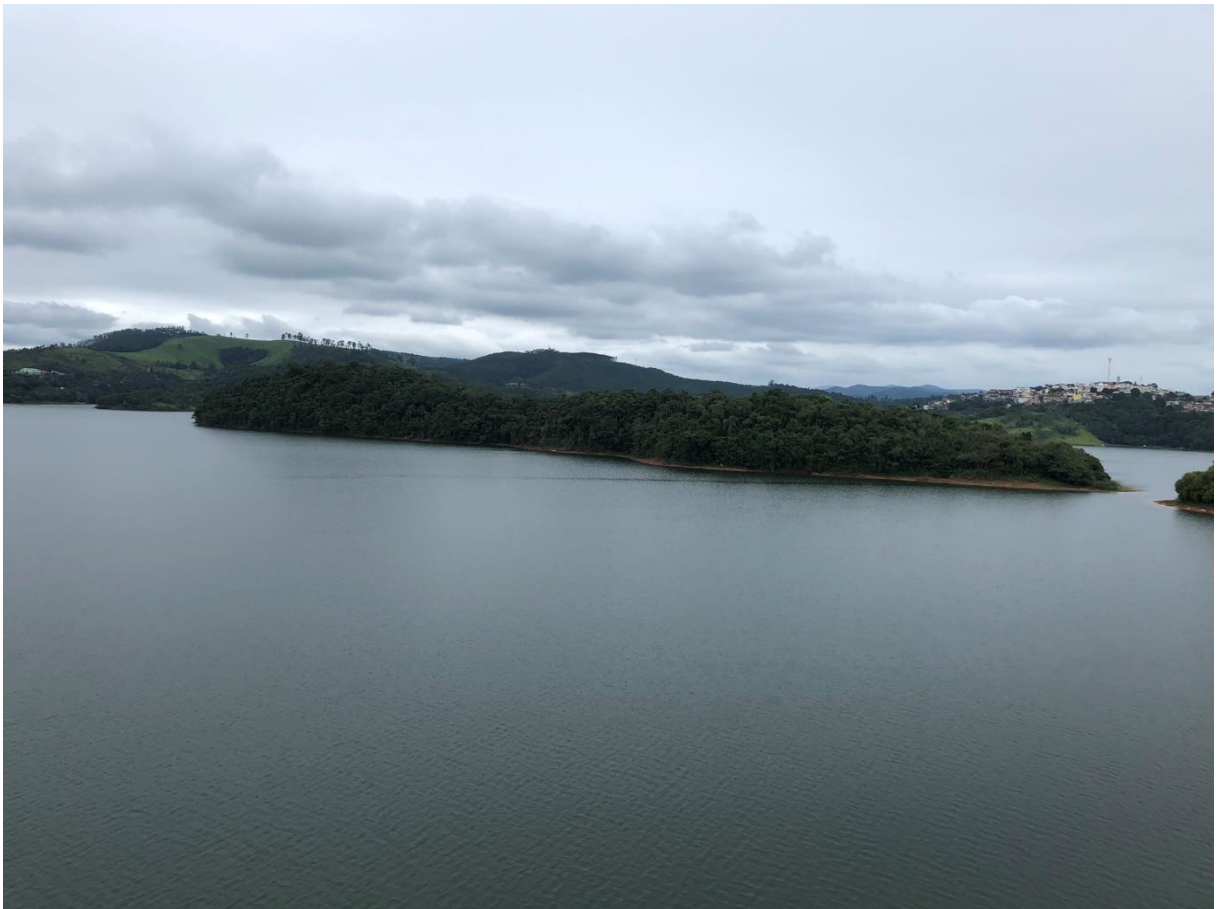
Reservatório de Jaguari-Jacareí (Jaguari, SP)
