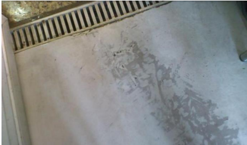
Figura 13: Porcelanato líquido com desgaste e riscos.
