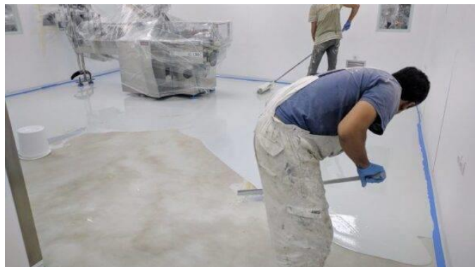
Figura 8: Aplicação do porcelanato líquido no contrapiso, a) com auxílio do rodo dentado e b) manualmente utilizando uma espátula.
