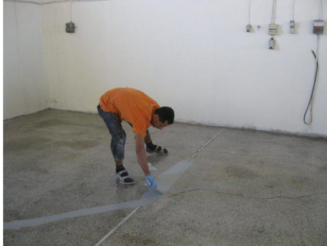
Figura 7: Preenchimento de trincos com a base niveladora para preparação do substrato.
