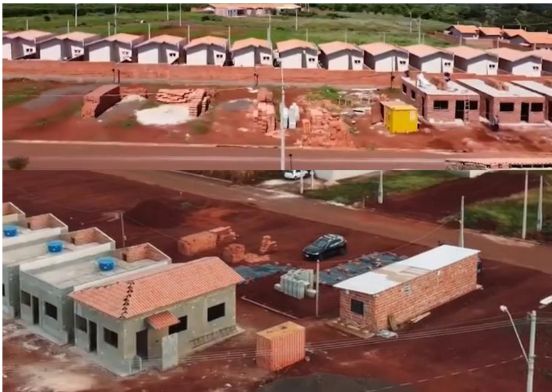
Figura 58 - Canteiro de obras da obra "B"
