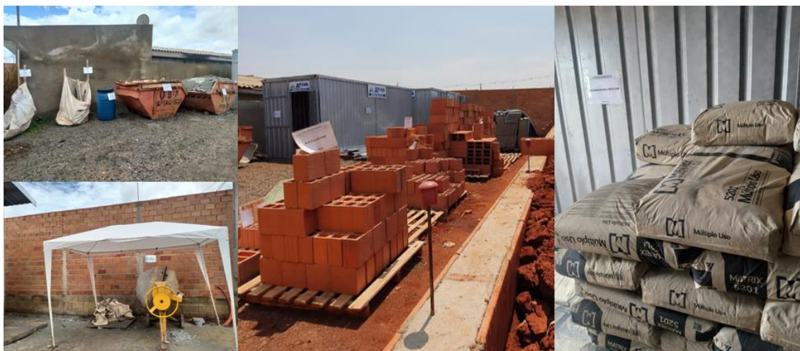
Figura 51 - Canteiro de obras da obra "A"
