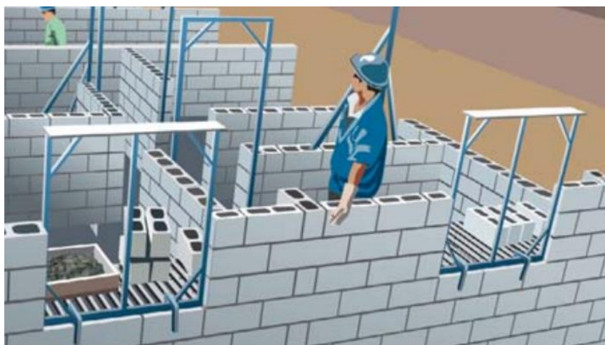
Figura 27 - Gabaritos de janelas instalados
