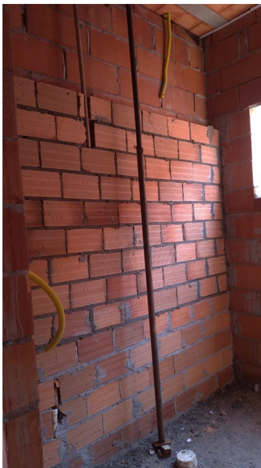
Figura 49 - Parede hidráulica executada no banheiro
