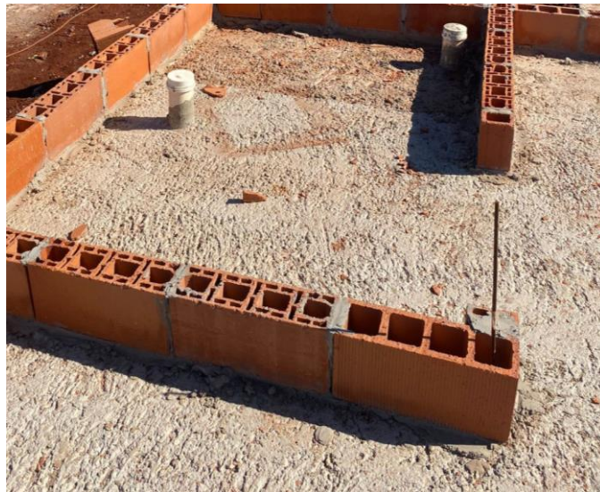
Figura 55 - Uso de blocos de paredes vazadas e maciças
