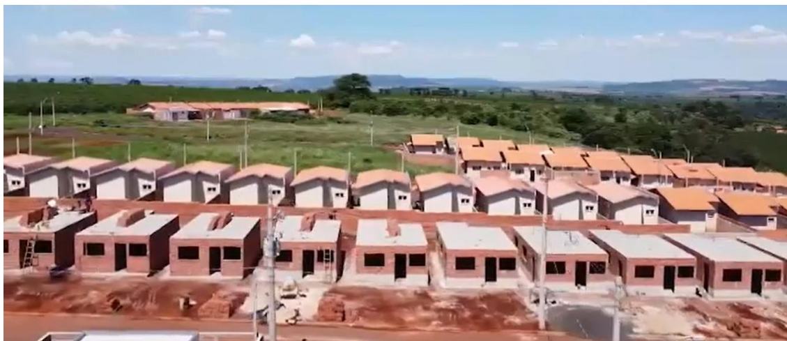
Figura 52 - Visão geral do empreendimento da obra "B"
