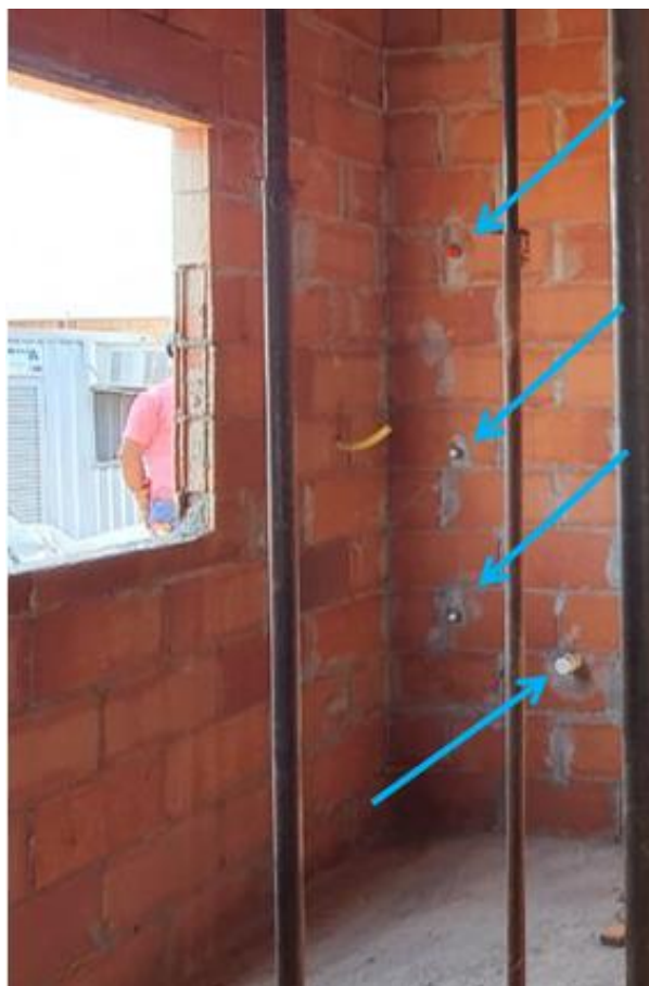
Figura 50 - Instalações hidrossanitárias saindo das paredes estruturais
