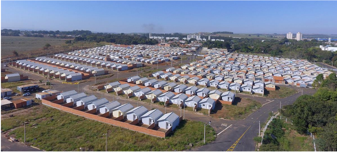
Figura 59 - Visão geral do empreendimento da obra "C"
