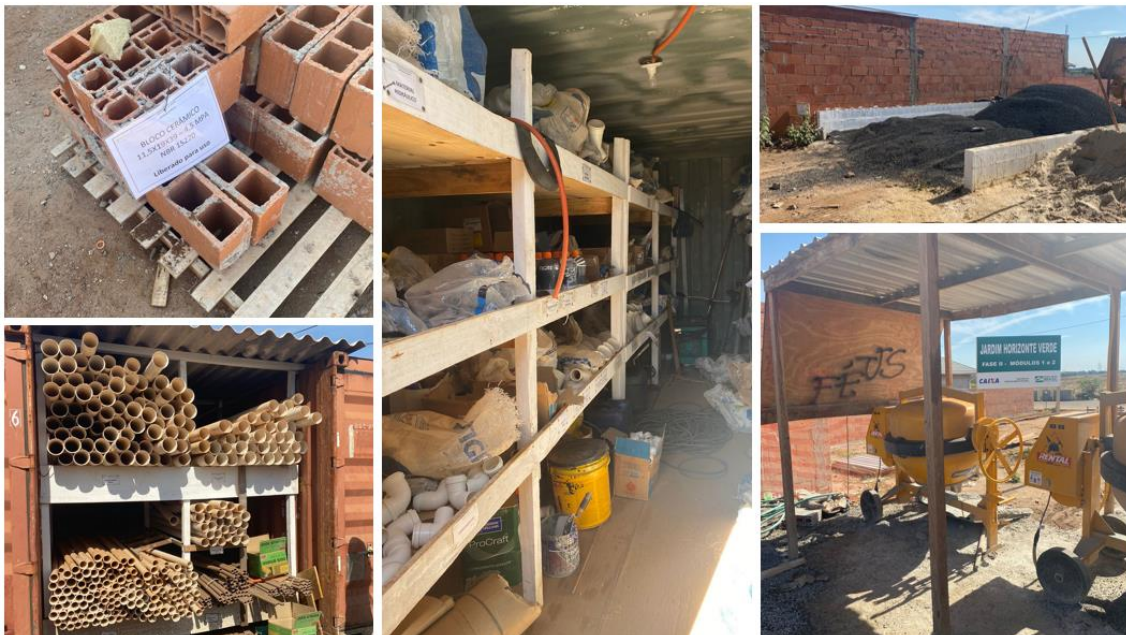
Figura 64 - Canteiro de obras da obra "C"
