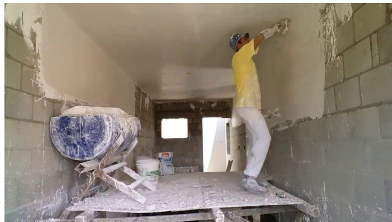
Figura 18 - Aplicação de pasta de gesso em paredes e teto
