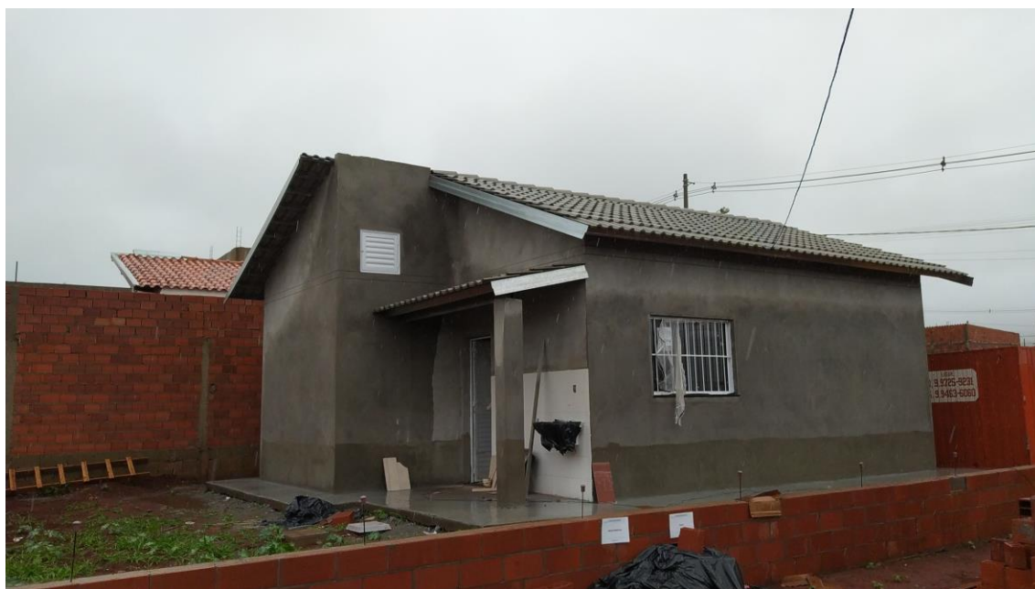
Figura 44 - Visão geral do empreendimento da obra "A"
