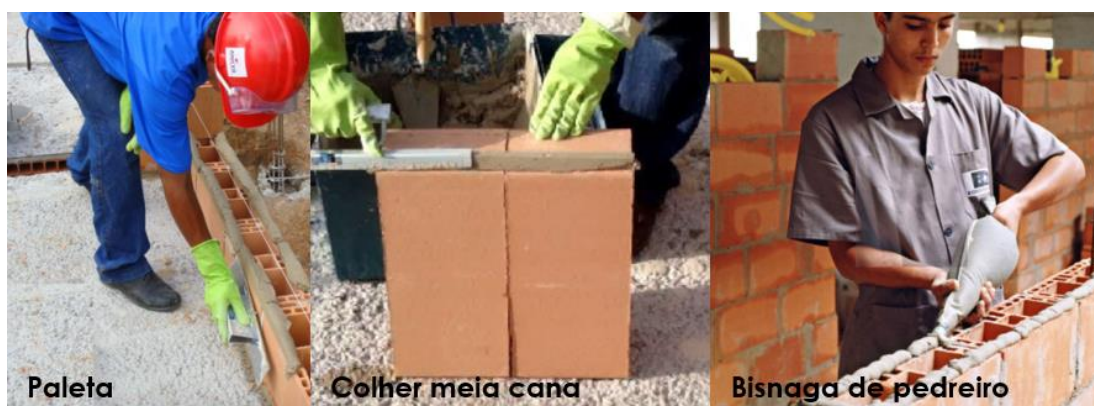
Figura 31 - Principais ferramentas para assentamento de blocos com argamassa
