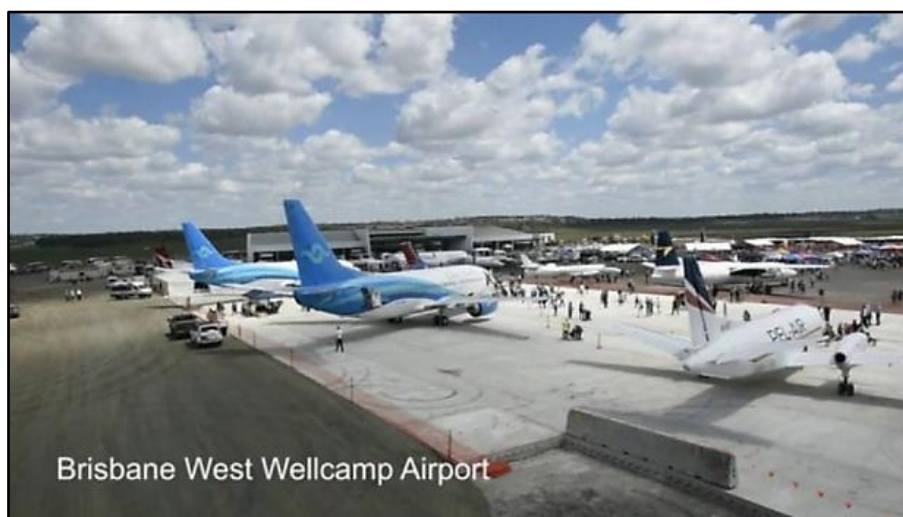
Figura 3.14 – Aeroporto de Brisbane West Wellcamp (Australia) construído com concreto geopolimérico [90].
