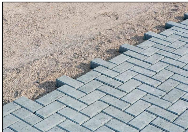
Figura 3.1 – Pavimento intertravado de peças de concreto pré-fabricadas [7].
