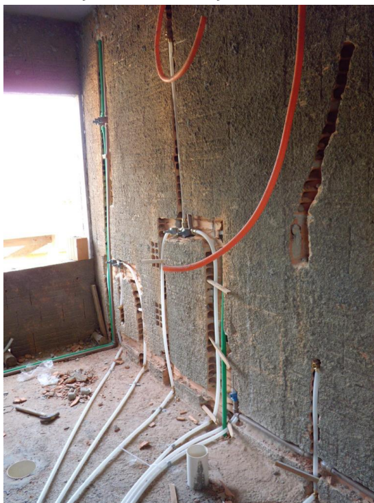
Figura 5 – Exemplo de execução das instalações hidráulicas em PEX e PPR
