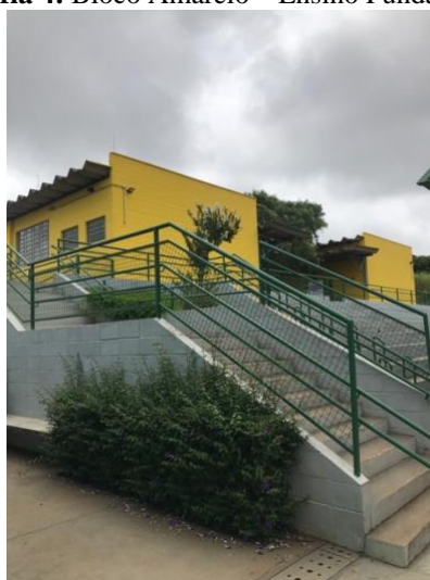
Fotografia 4: Bloco Amarelo – Ensino Fundamental II
