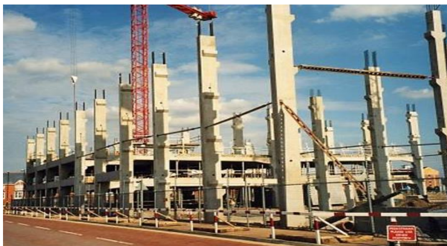
Figura 4.3: Escoramento e estaiamento realizados em pilares esbeltos.
