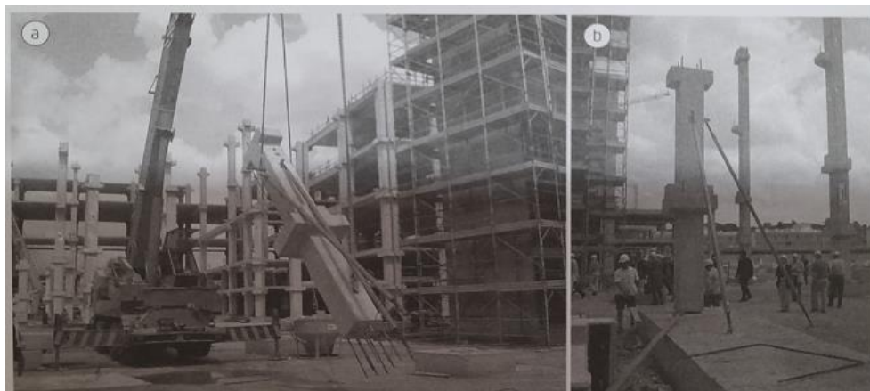
Figura 2.6: Exemplo de dispositivo auxiliar de montagem: (a) Içamento com o dispositivo; (b) Montagem com o dispositivo fixado.
