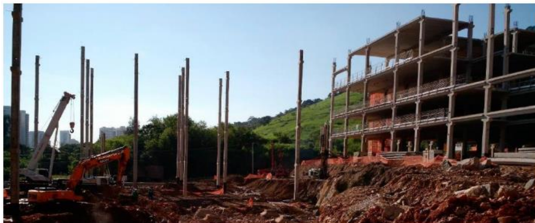
Figura 4.2: Montagem dos pilares pré-moldados de concreto armado.
