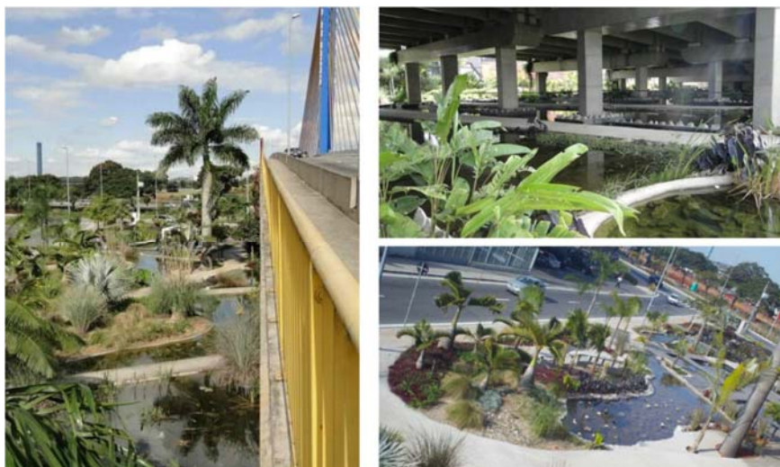
Figura 6 – Bacias de retenção integradas a espelhos d'água sob viaduto em Guarulhos/SP
