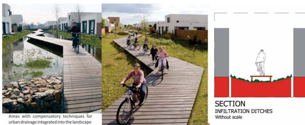
Figura 7 - Grande vala destinada a infiltração do escoamento das residências localizadas no entorno
