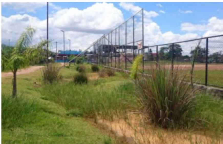
Figura 5 – Valas de infiltração integradas a Campo de Futebol em Guarulhos/SP
