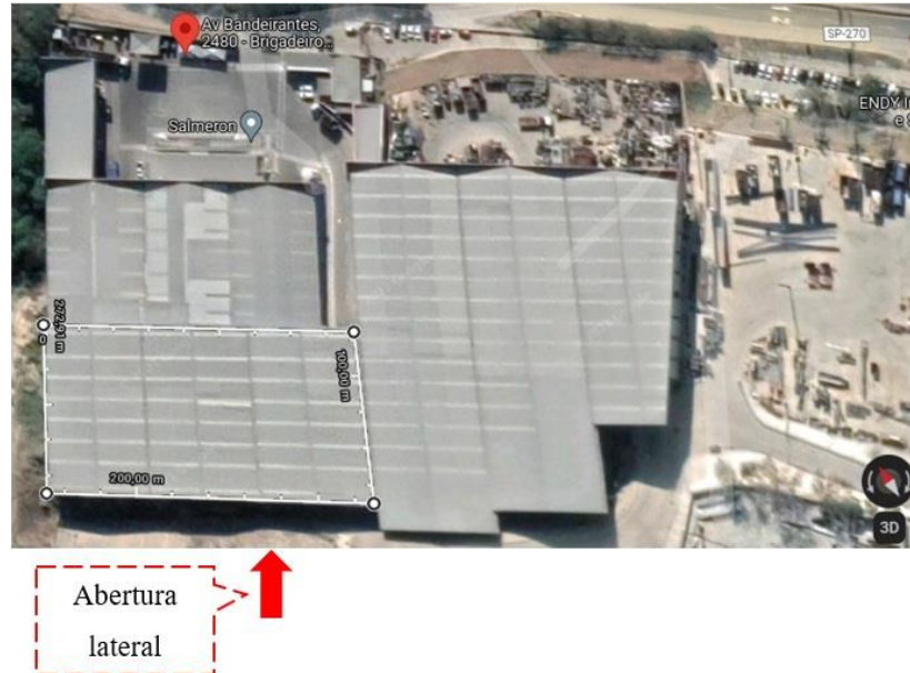
Figura 19 - Vista de cima da localização do galpão da Salmeron Sorocaba-SP
