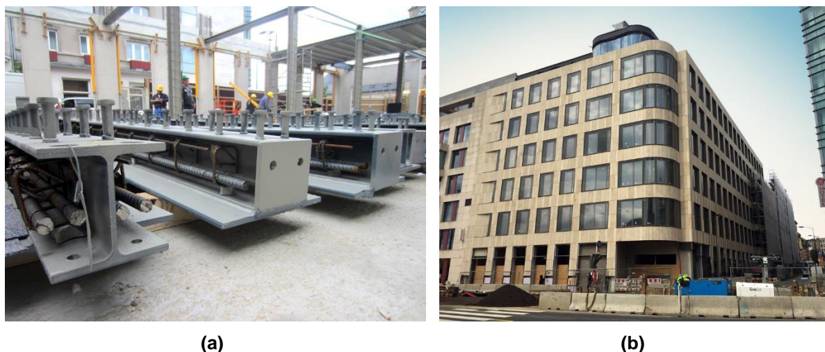
Figura 1.6: Construção do Edifício Kons (2016)
