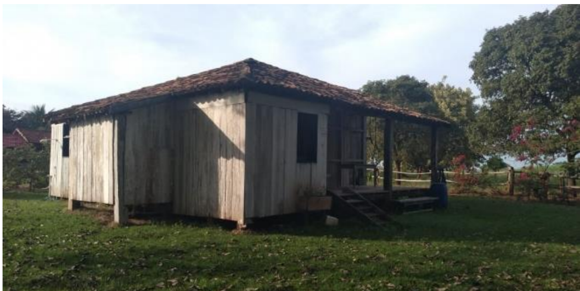
Figura 3: Casa de Afonso Cáfaros
