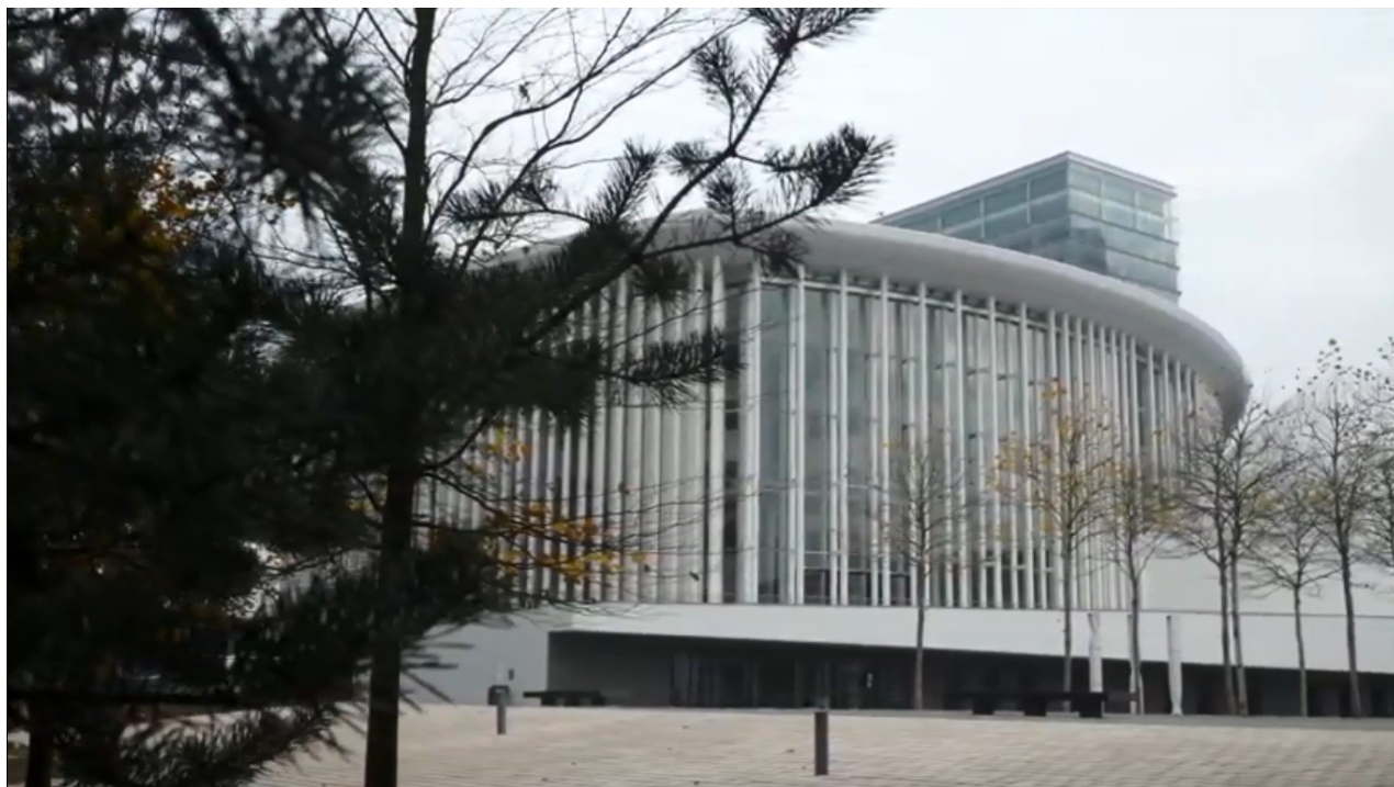
Figura 3: Visão externa do local da instalação. (ON AND BETWEEN, S.I.:s.n.)
