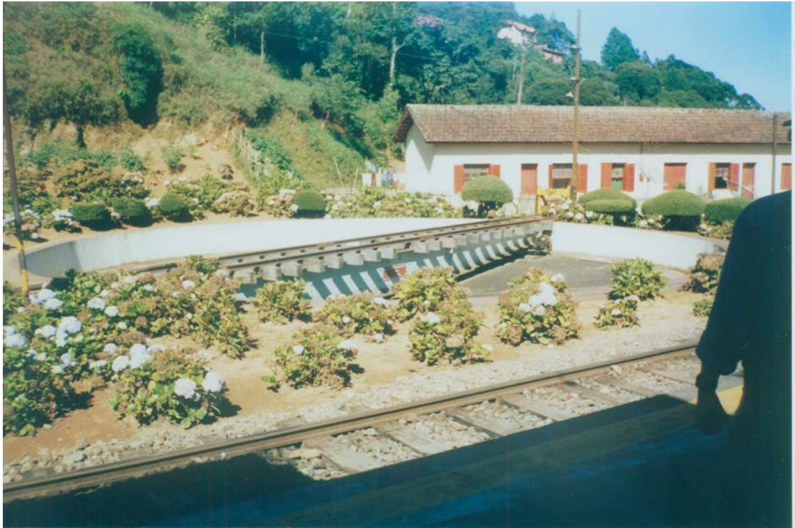
Figura 7-9: Rotunda para manobra do vagão ferroviário Fonte: foto de David L. Rosalen (Abr/2000)
