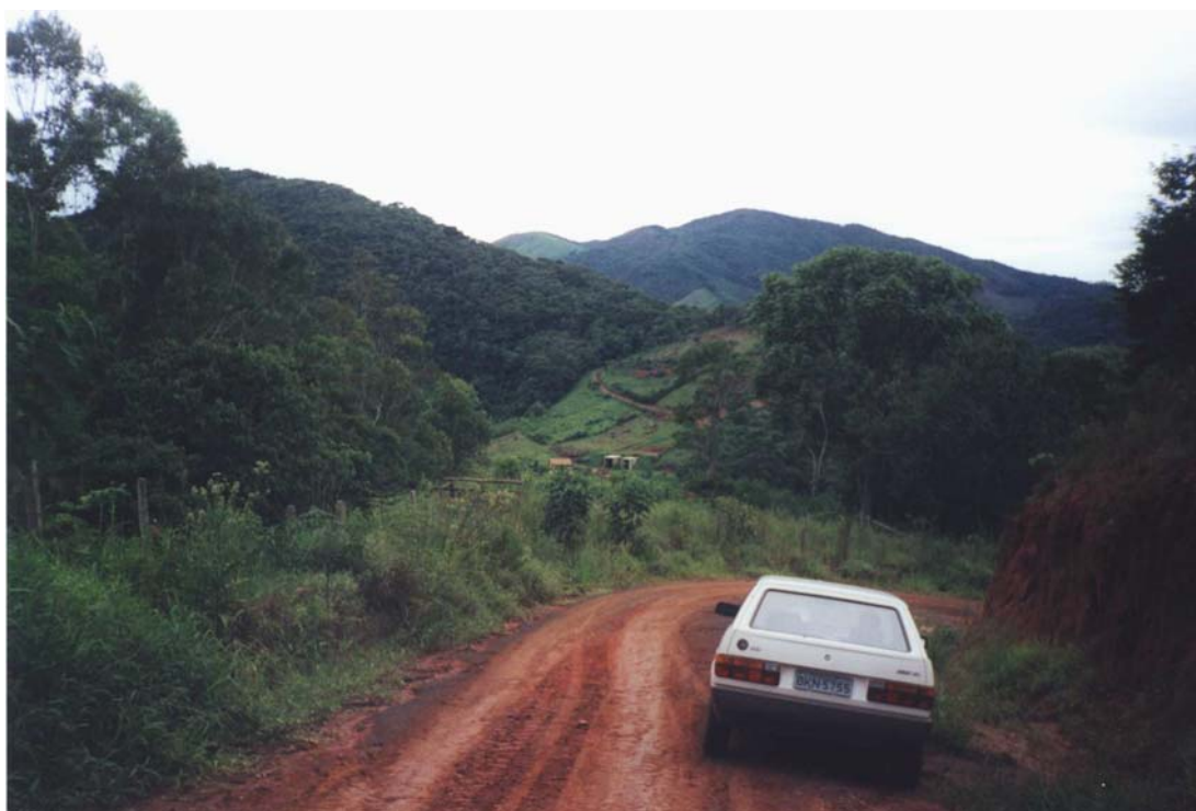
Figura 7-18: Vista cênica da Estrada do Barreiro Fonte: foto de David L. Rosalen (Jan/2001)
