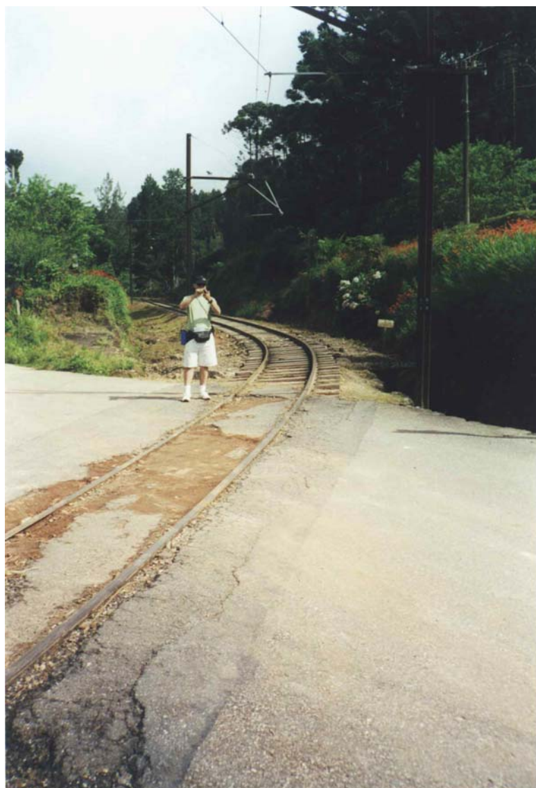
Figura 7-14: Proximidades do início do primeiro trecho da Trilha do Alto do Lageado, onde a antiga estrada de Campos do Jordão corta a via férrea Fonte: foto de David L. Rosalen (Jan/2001)
