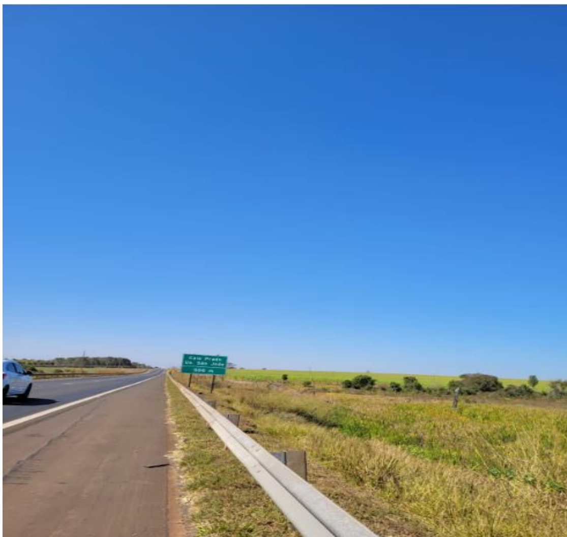
Figura 23. Panorâmica da Estrada de acesso ao bairro Caio Prado (Acervo Pessoal; 30 de jul. 2022)
