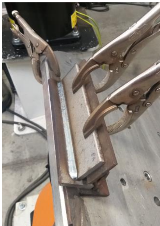
Figura 31: Aspecto visual do cordão de solda associado ao teste inicial para cordão a5 e posição 1F.
