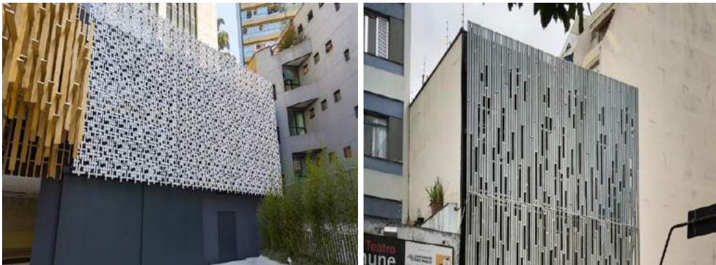
Figuras 2.10 – Elementos arquitetônicos produzidos com CUADRF no Brasil: (a) painel de cobogó da casa Japão (esquerda); (b) painel da fachada do edifício do ERESP (direita).
