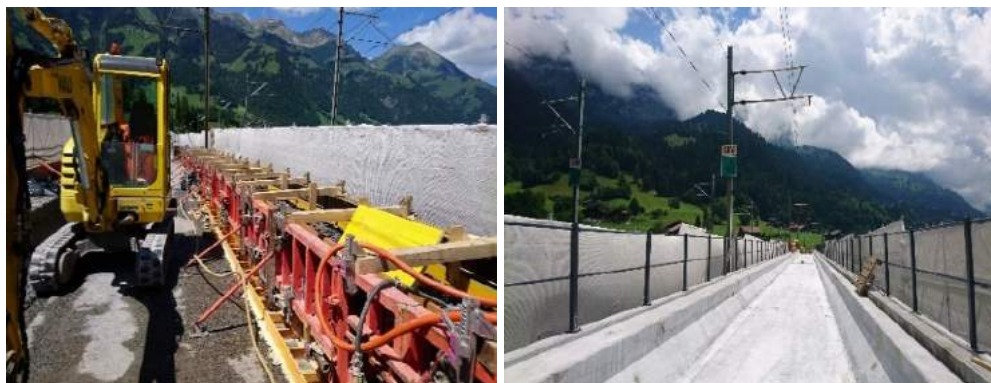
Figura 2.9 – Kanderviadukt (Suíça): foi aplicada uma camada de 30 mm de CUADRF para proteger a estrutura contra infiltração de água e demais agentes agressivos.
