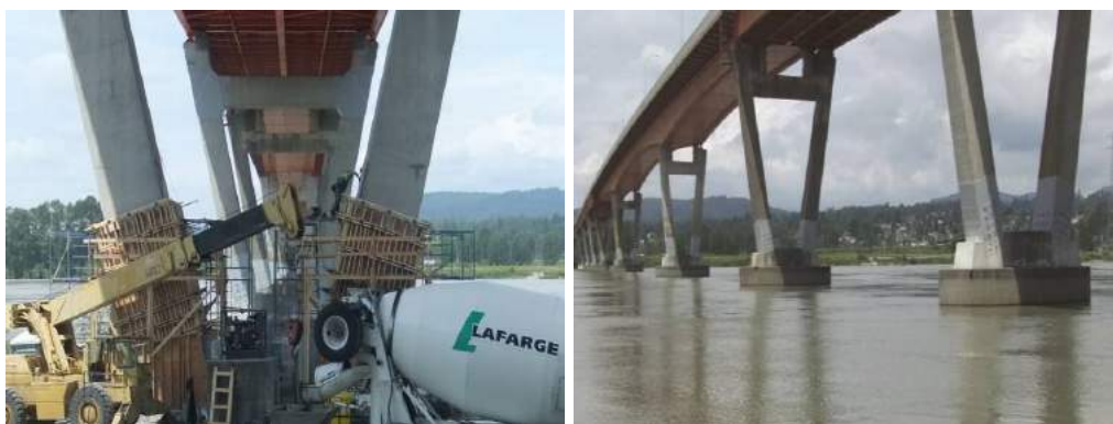
Figura 2.8 – Mission Bridge (Canadá): foi realizado um encamisamento de 225 mm de espessura com CUADRF para a adequação da ponte aos requisitos sísmicos.
