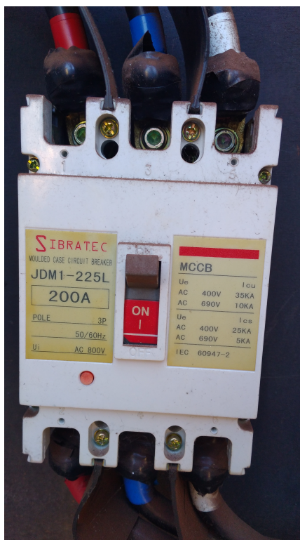
Figura 31 – Proteção geral da unidade consumidora
