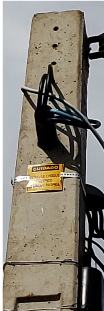
(b) Vista focada na placa de advertência fixada na entrada de energia
