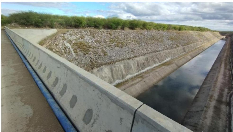
Figura 23: Ponte para acesso de moradores localizada na comunidade Pau D'arco
