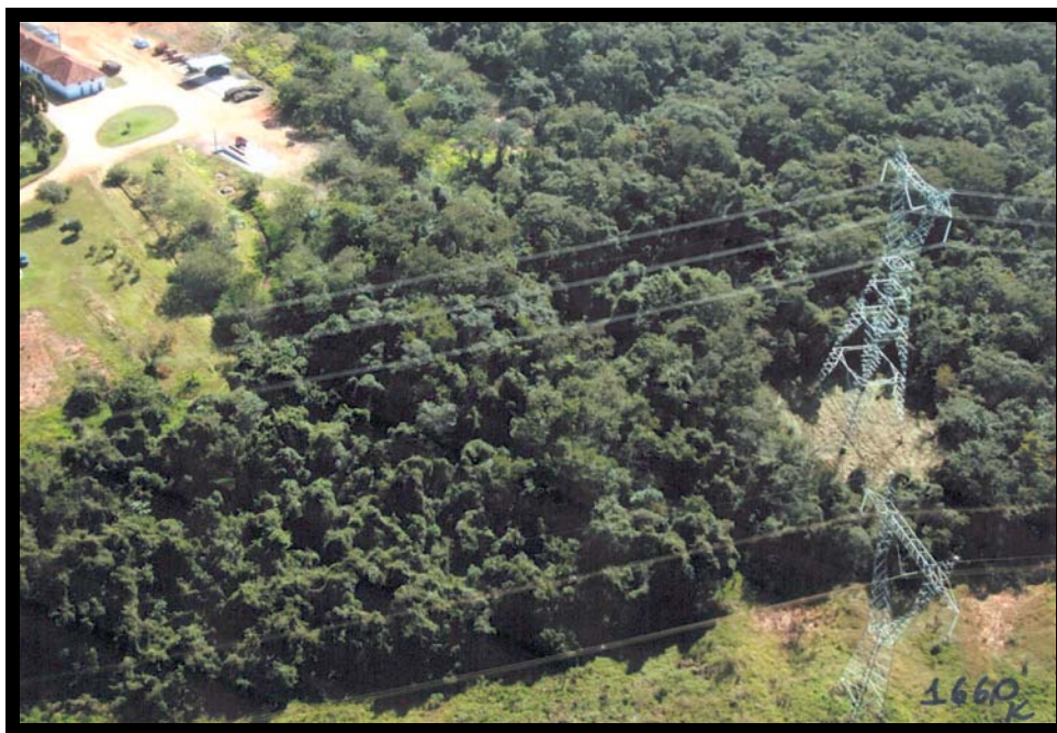
Figura 17. Fotografia aérea evidenciando a inserção da torre de transmissão autoportante 210/1 em área de Cerrado (cerradão), nas proximidades da sede da Fazenda Flecha Azul I. Martins Filho, C. A. de S. (2008).
