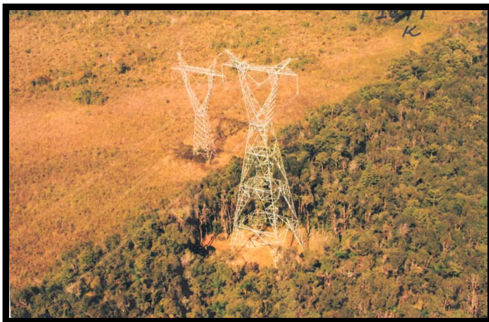
Figura 8. Fotografia aérea identificando a torre de transmissão autoportante 228/2, visualizando-se a picada de serviço (área de supressão vegetal). Martins Filho, C. A. de S. (2008).
