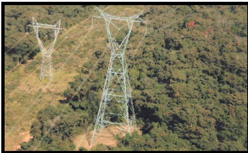
Figura 27. Fotografia aérea evidenciando a base de uma das torres de transmissão autoportantes localizadas na Fazenda Pântano. Martins Filho, C. A. de S. (2008).
