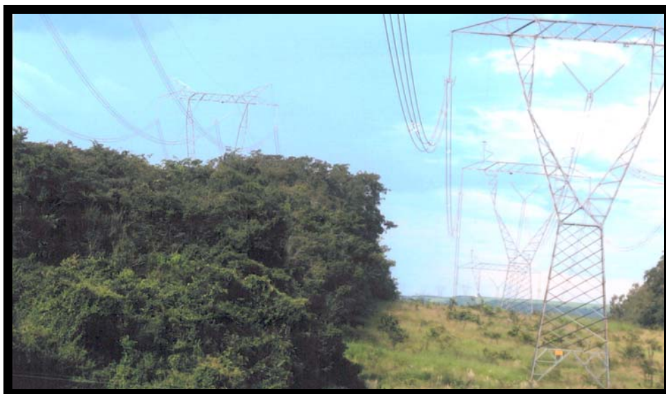
Figura 41. Fotografia evidenciando a diferença entre os tipos de supressão vegetal entre a LT Londrina (PR) – Araraquara (SP), sub-trecho Boa Esperança do Sul (SP) – Araraquara (SP), e a LT instalada pela Companhia de Transmissão de Energia Elétrica Paulista.
