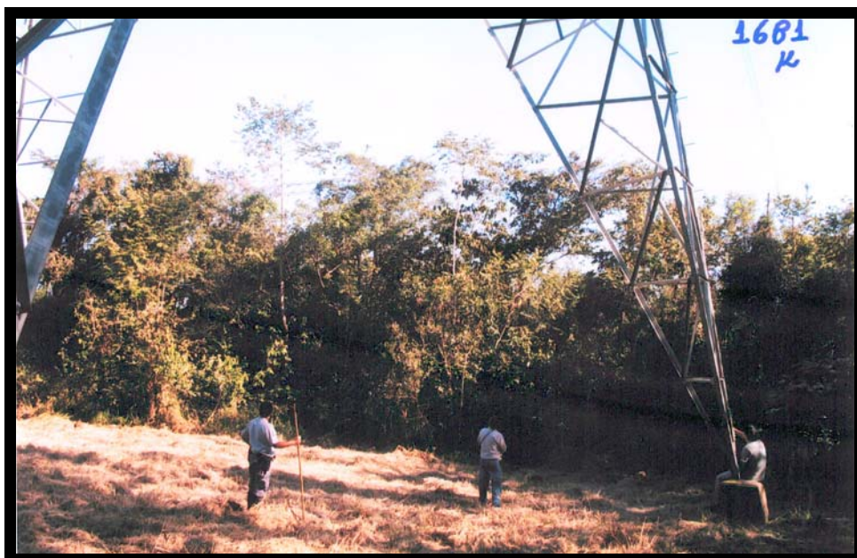
Figura 38. Fotografia evidenciando a vegetação no entorno da base da torre de transmissão autoportante 200/1, localizada na Fazenda Flórida. Martins Filho, C. A. de S. (2008).
