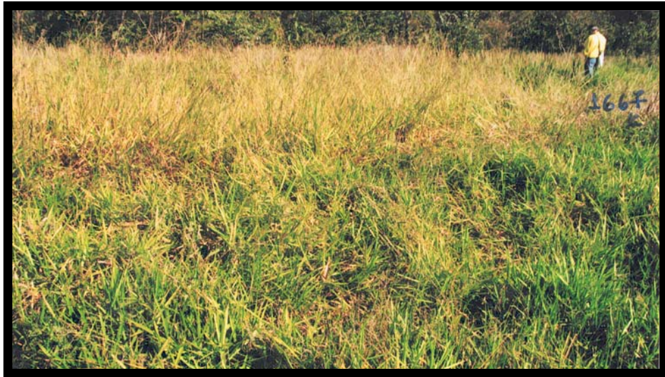
Figura 24. Fotografia evidenciando a vegetação de gramíneas na base da torre de transmissão autoportante 212/2. Martins Filho, C. A. de S. (2008).
