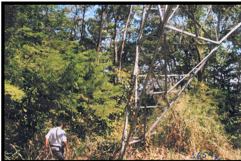
Figura 13. Fotografia identificando as condições da vegetação no entorno da base da torre de transmissão autoportante 219/1. Martins Filho, C. A. de S. (2008).
