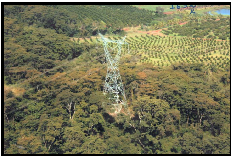
Figura 11. Fotografia identificando a torre de transmissão autoportante 219/1, localizada na Fazenda Pedra Branca, evidenciando a condição de declividade que caracteriza essa área como uma APP. Martins Filho, C. A. de S. (2008).
