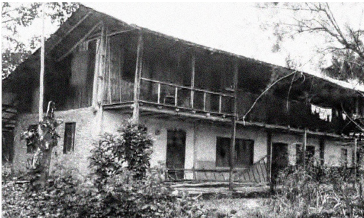
Antigo edifício da Missão Sagrada Família do Marauiá, construída pelo padre Antônio Góes, sem data. Fonte: Laudato (1998:46).
