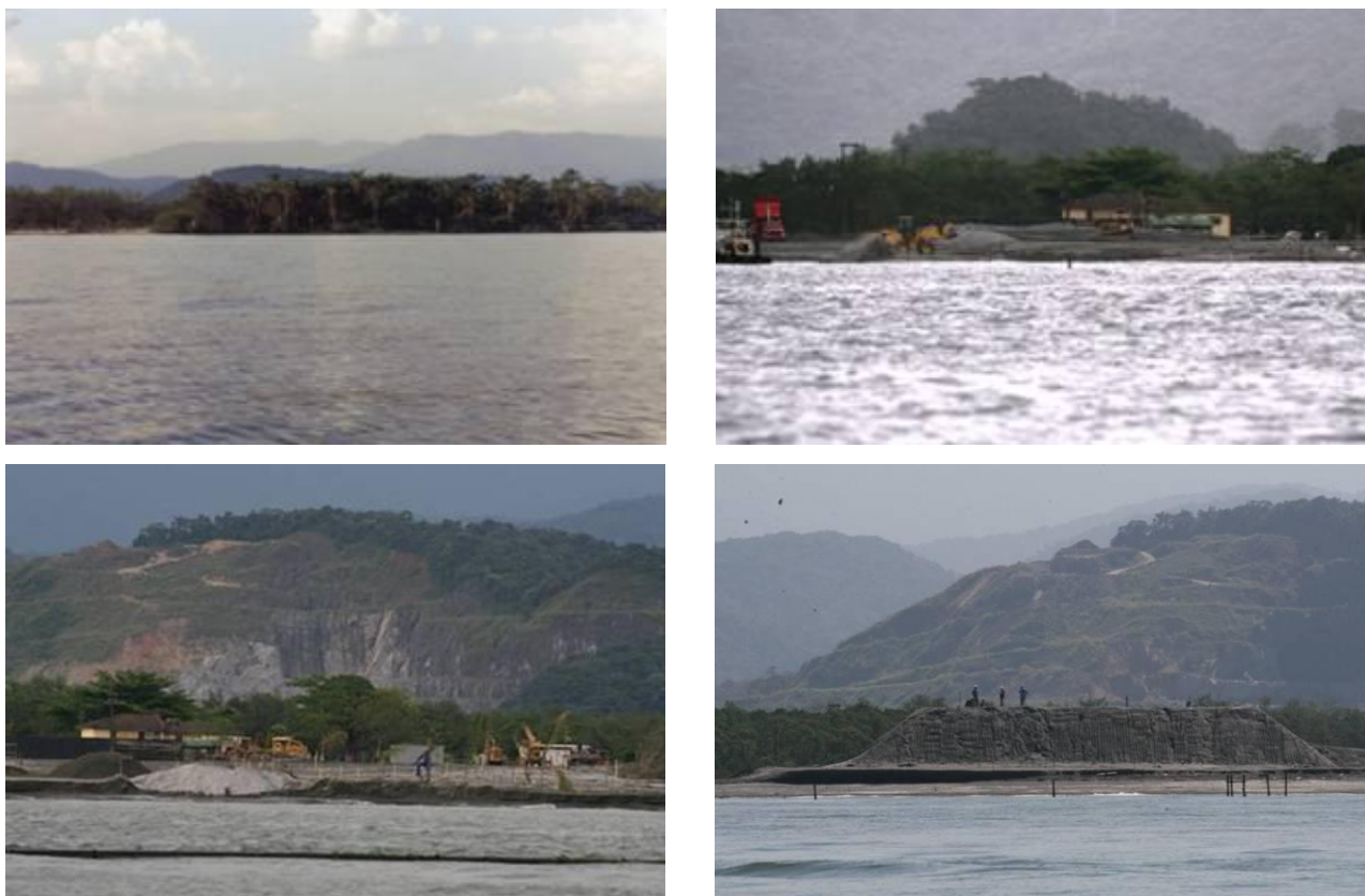
Figura 28: Transformações da paisagem do Guarapá decorrentes da obra de instalação do Terminal Embraport (imagens da autora).
