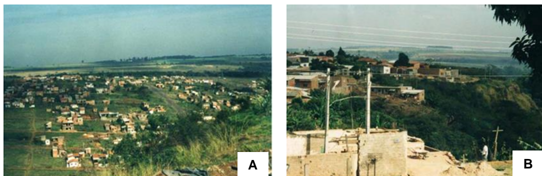
Figura 18 – A: Construção das moradias sem a infraestrutura necessária; B: construções em terrenos com altas declividades e altamente permeáveis.
