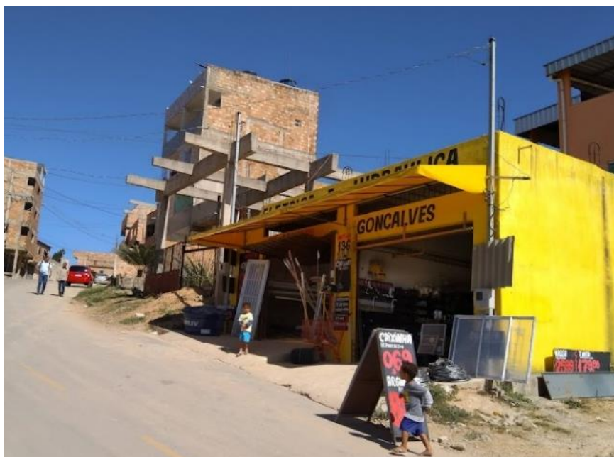
Figuras 24 e 25. Depósitos de materiais de construção dentro da Dandara
