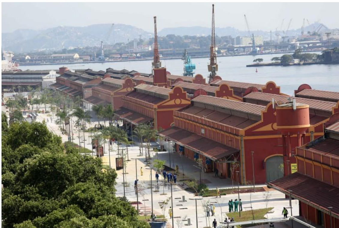
Figura 12. Aspectos dos galpões antigos do porto, transformados em atrações culturais e turísticas.
