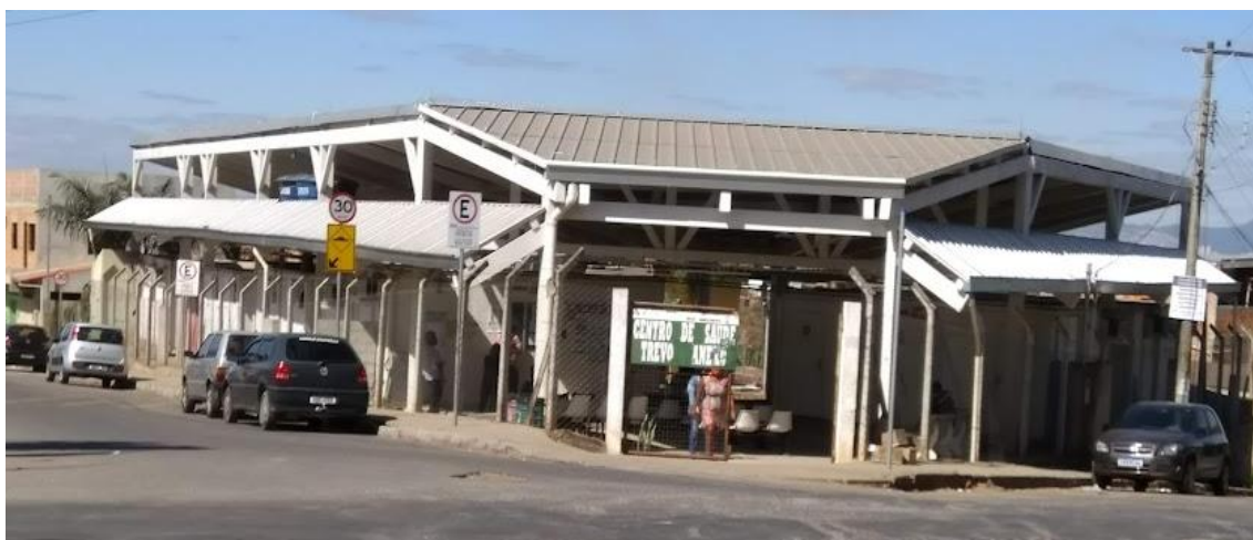
Figura 21. Posto de Saúde Municipal, na entrada da Ocupação
