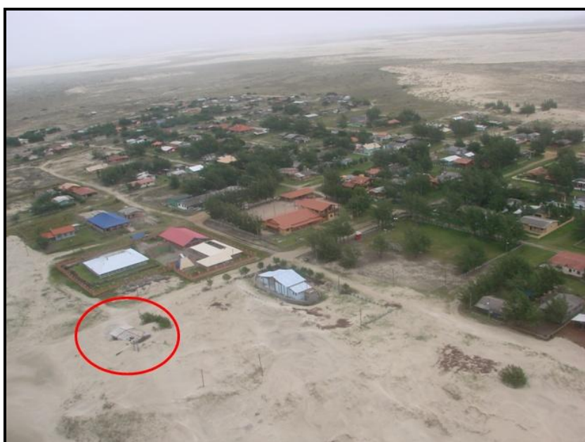
Figura 5. Foto aérea do balneário São Simão com destaque para as construções sobre as dunas; no círculo uma residência "engolida" pela areia.
