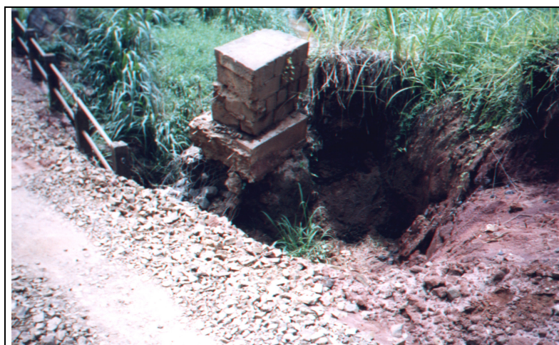
Figura 5.1 – Foto do Ponto de controle 01.
