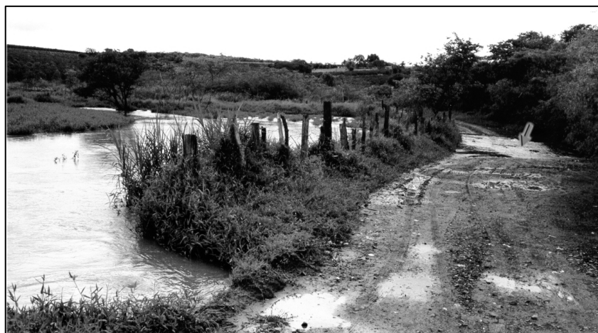
Figura 3.14 – Transbordamento do Rio Bonito – Fonte: TOREZAN (2000).
