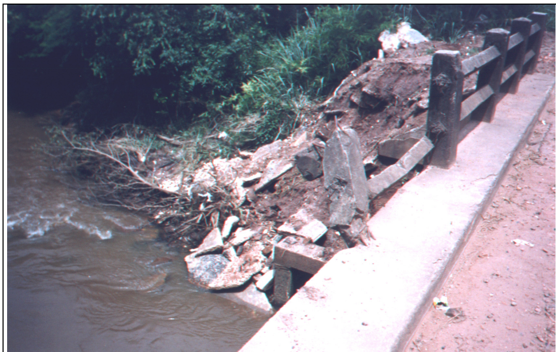
Figura 5.2 – Foto do Ponto de controle 02.
