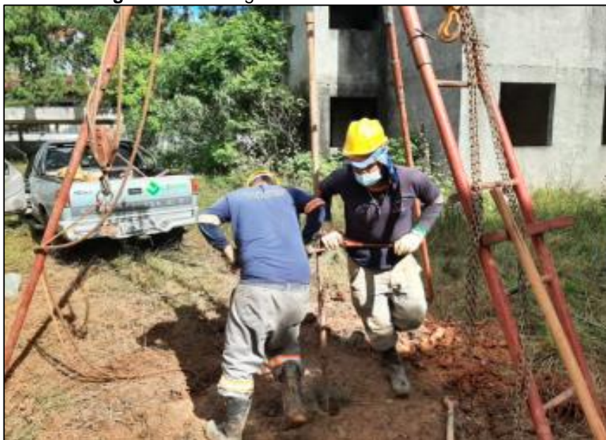
Figura 9 – Sondagem com trado manual helicoidal
