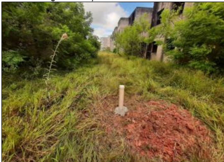
Figura 11 – Poço de monitoramento instalado
