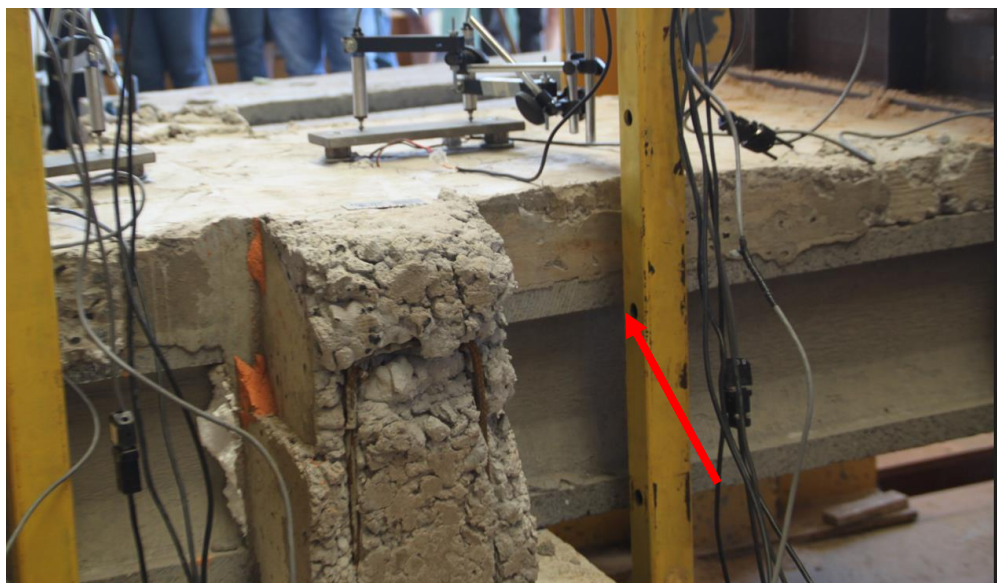
Figura 103: Início do destacamento da capa – laje com capa e continuidade
