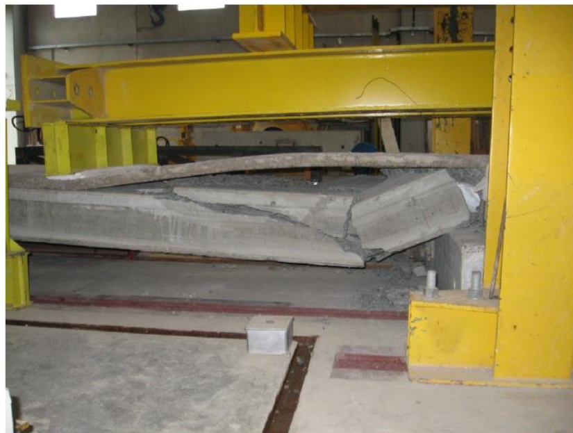
Figura 49: Vista da lateral que sofreu ruptura
