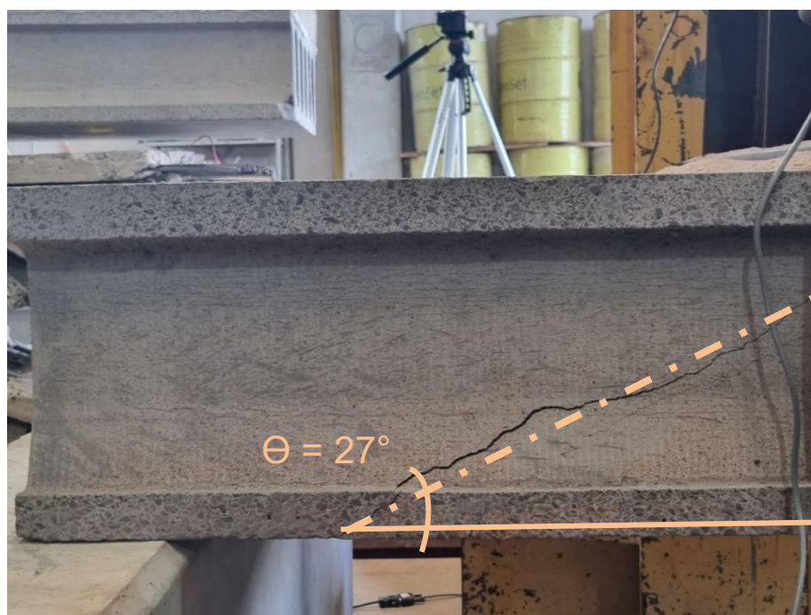
Figura 73:Fissura de Ruptura – Lado Direito– Laje 1
