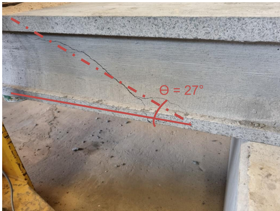
Figura 72: Fissura de Ruptura – Lado Esquerdo – Laje 1
