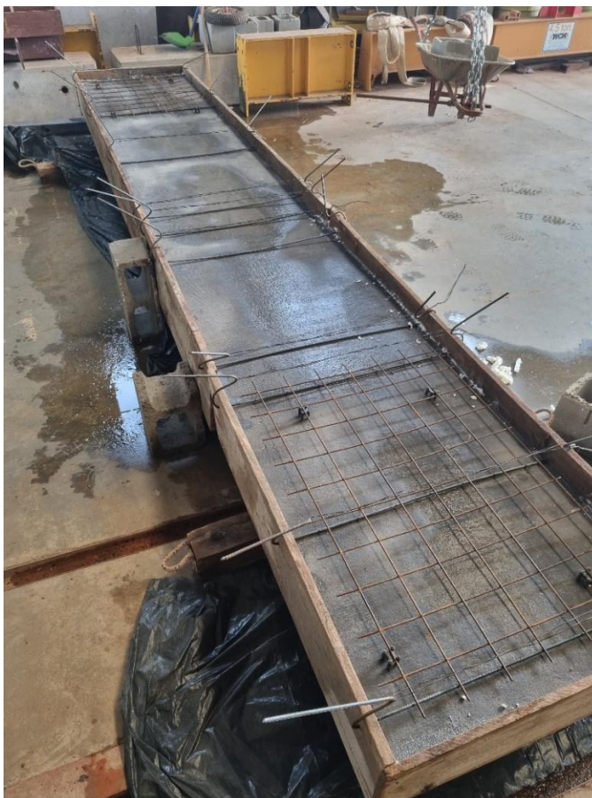
Figura 57: Forma e armação da laje alveolar que receberá capa
