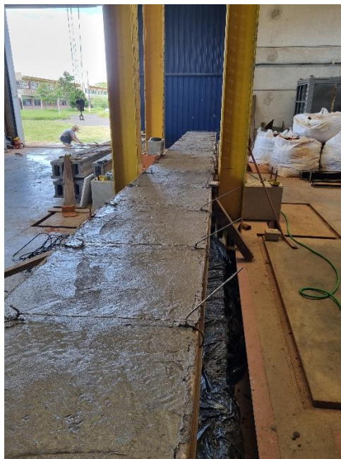
Figura 62: Processo de cura lajes contínuas com capa
