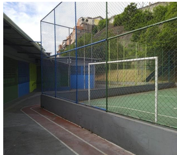
Figura 2: Espaço entre quadrinha e prédio anexo.
