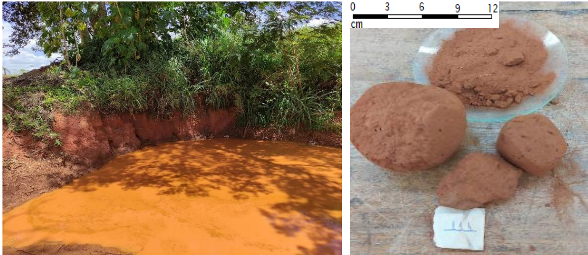
Figura 36 – À esquerda, caixa de contenção de erosão; à direita, amostra da rocha alterada mole
