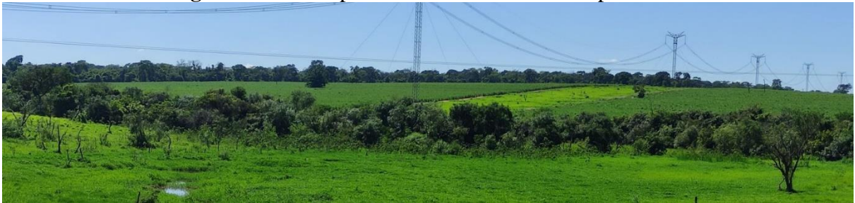
Figura 53 – Vista panorâmica do sistema 1 no ponto 242
