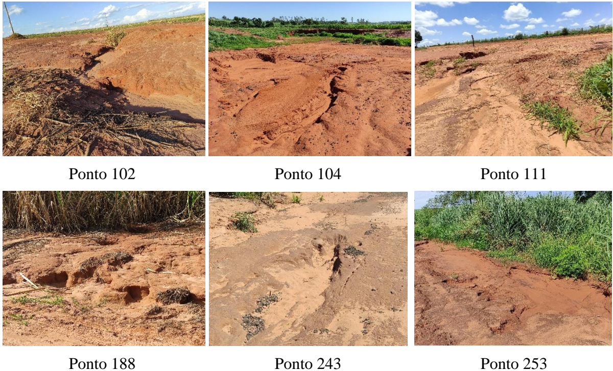
Figura 62 – Processos erosivos nas estradas rurais e carreadores
