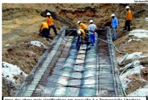
Uma das obras mais significativas em execução é a Transposição Litorânea
