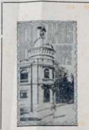
Este é o edifício comemorativo das 70 anos da A UNIÃO, construído a um custo de Cr$ 10 milhões. O edifício foi inaugurado em 1902, mas já a partir da edição de sexta-feira próxima o edifício será utilizado permanentemente no local de trabalho da UNIÃO.
