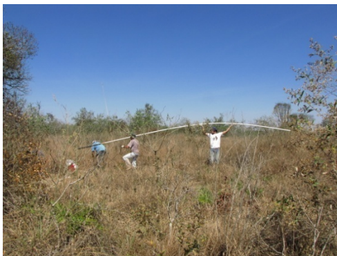
Figura 10- Poço para medição do Lençol freático, a) Canos de PVC furados e b) Canos prontos para serem instalados, c) Instalação dos poços d) Cano no seu lugar definitivo.
