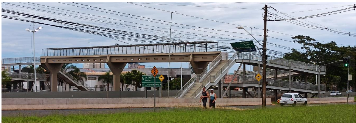
Figura 12 - Passarela de pedestres sobre a Av. Pres. Castelo Branco, no percurso entre o AMB Leste e os Espaços de Lazer EL. 7A e EL.7B
