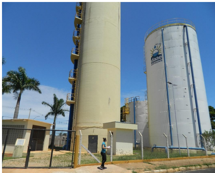
Figura 27: Poço tubular de abastecimento público no 648 localizado na Rua Carlos Alberto Alves de Carvalho Pinto, Jardim Roberto Selmi Dei.
