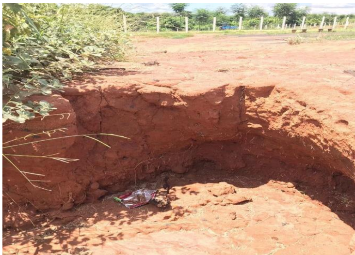
Figura 36: Erosão em novo residencial.
