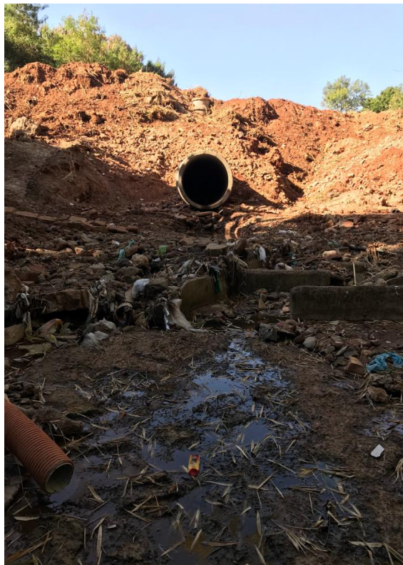
Figura 38: Obras de contenção à erosão e de melhoramento na rede de água pluvial
