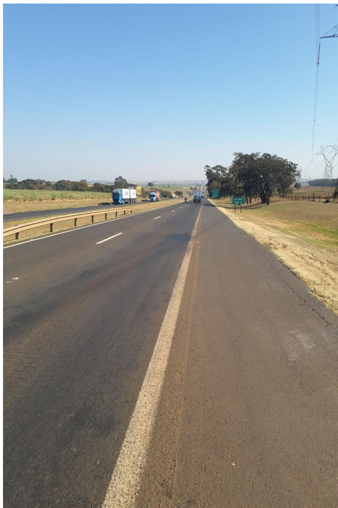
Figura 6 - Trecho da SP-310 entre Araraquara e Matão
