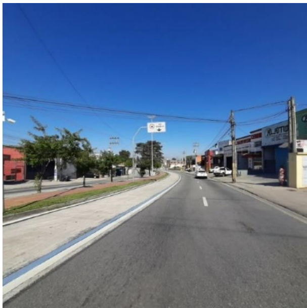
Figura 72 – Início da região adensada na Avenida Itavuvu. Fonte: elaborado pela autora.
