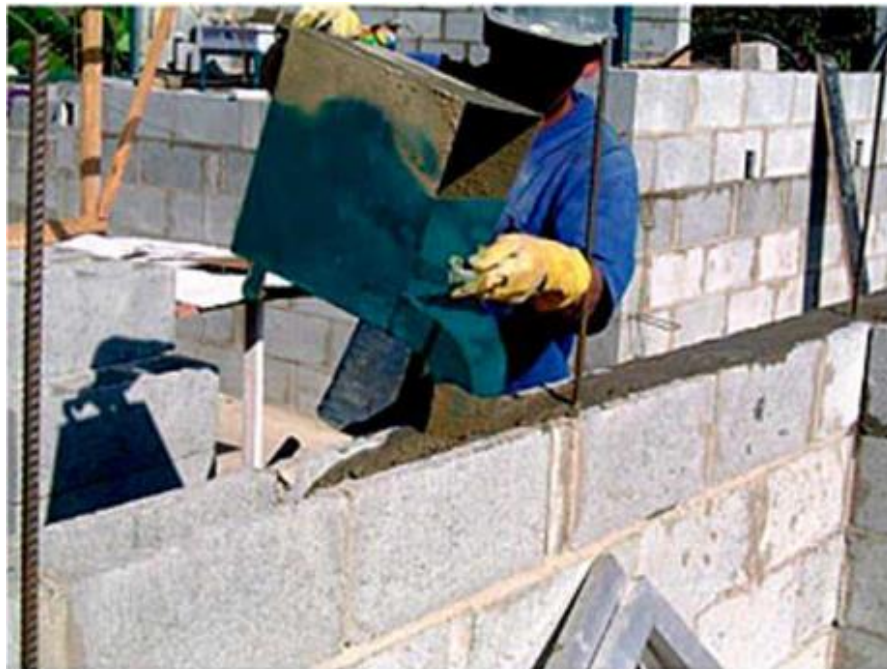
Figura 2.7 – Lançamento manual do graute na alvenaria.
