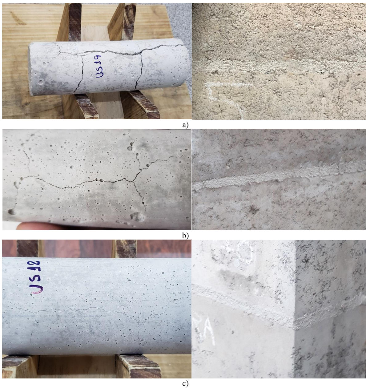
Figura 4.28 – Degradação da argamassa moldada em cilindros e disposta na junta dos prismas após 600°C: a) AC5; b) AC10; c) AC20; d) AI5; e) AI10; f) AI20.
