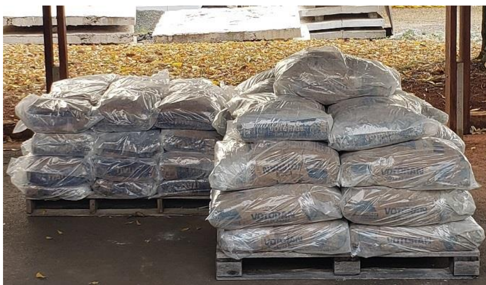
Figura 3.2 – Aglomerantes dentro de sacos plásticos e sobre paletes de madeira.
