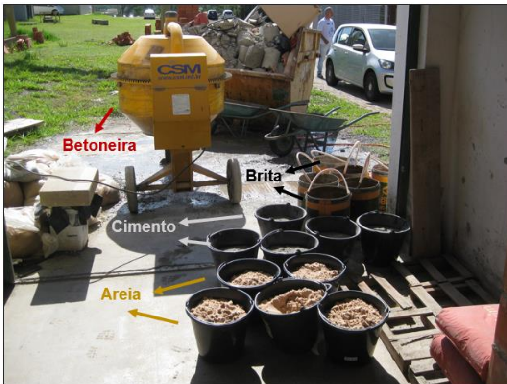
Figura 70. Separação dos materiais para o início da moldagem.
